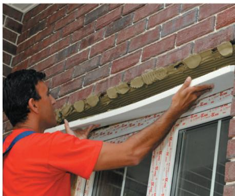
3. Підготуйте елемент відкосу для монтажу. На місця зіткнення елемента з несучою поверхнею нанесіть клейову будівельну суміш.
